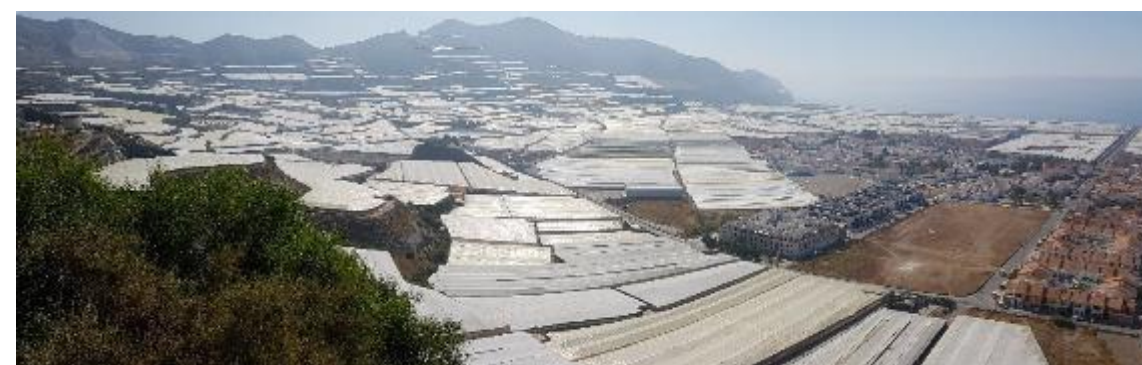
Zona de invernaderos en el municipio de Motril, donde se ilustra el aumento del efecto albedo que provocan estas infraestructuras, contribuyendo al enfriamiento de la superficie terrestre.
